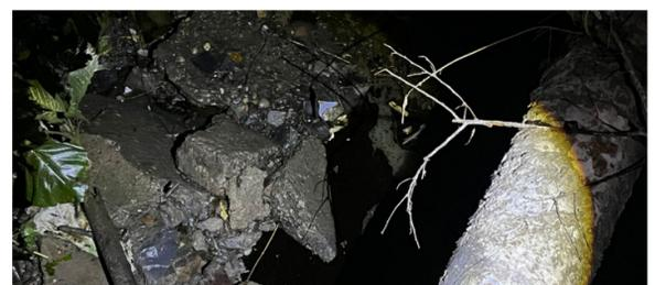
lograron identificar la ruptura de una tubería que provocaba el derrame de hidrocarburos sobre el agua de este arroyo.
